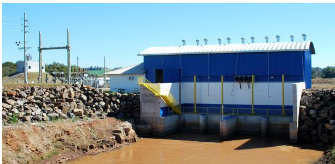
Figura 14 - Câmara de carga antes da casa de força da PCH RS-155.
