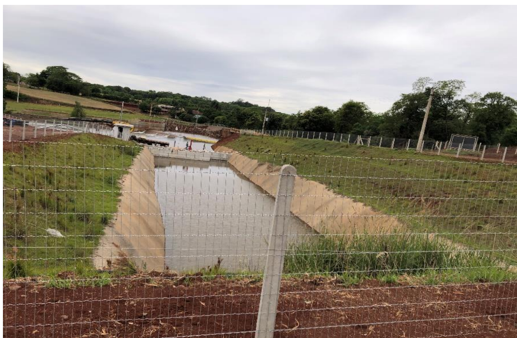
Figura 13- Canal adutor - Visão do emboque do túnel - PCH Ijuí Centenária, Ijuí - RS.
