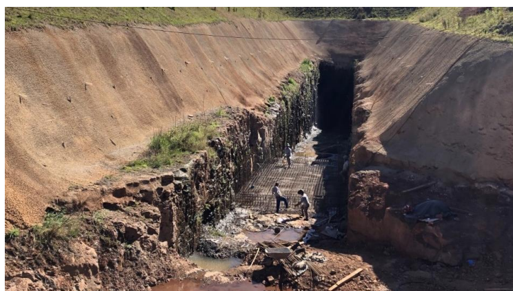
Figura 17 - Emboque do túnel na fase de Instalação, Ijuí - RS.
