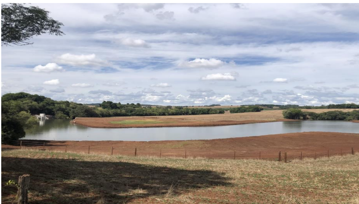
Figura 9 - Reservatório Fio d'água na fase de instalação da CGH Formigueiro- Boa Vista do Cadeado- RS.
