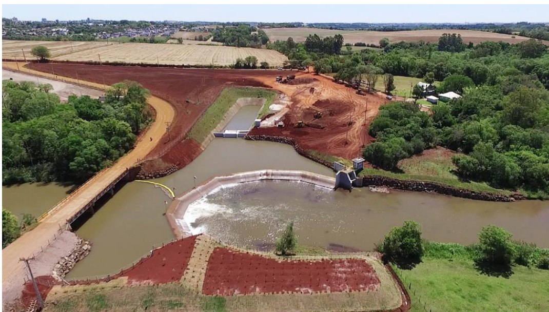
Figura 10 - Barragem de concreto na PCH Ijuí Centenária - 7,9 MW.
