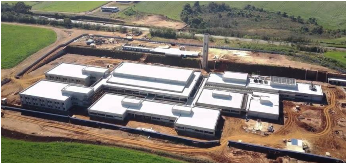
Figura 3 - HPR de Palmeira das Missões ainda em construção.
