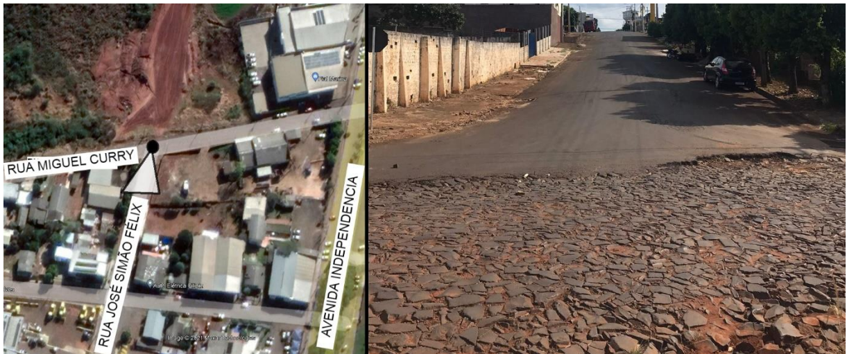
Figura 26 - Condições atuais Rua José Simão Félix, encontro com a Miguel Curry.
