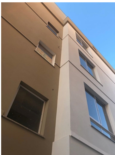
Figura 40 – Execução das janelas da escadaria
