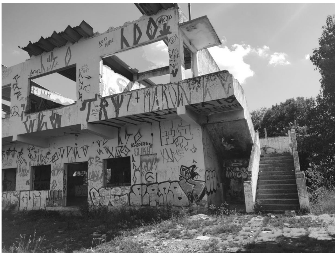
Figura 38- Cena 19 – Edifício degradado no interior do Parque Urbano Jockey Club em Santa Maria
