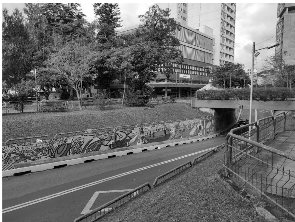
Figura 25- Cena 6 – Viaduto Evandro Behr no Centro de Santa Maria
