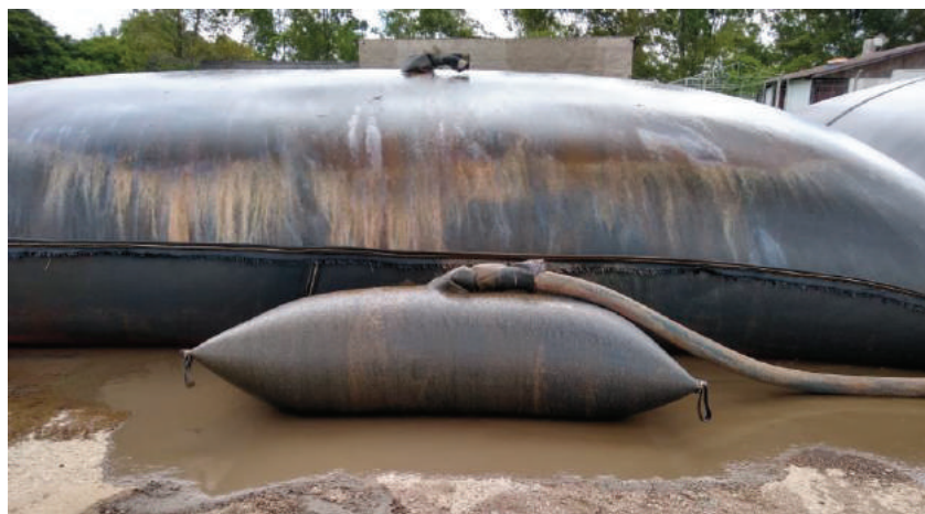
Figura 3 – Bag geotêxtil utilizado para armazenagem do lodo
