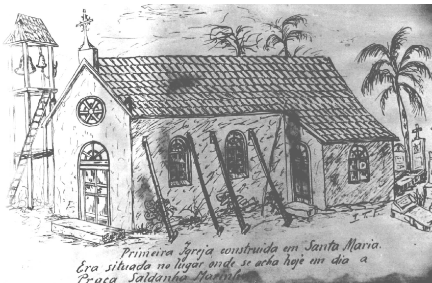
Figura 1 – Antiga capela e cemitério
