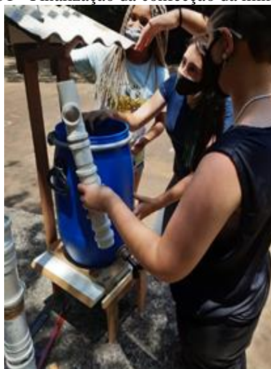
Figura 51 - Finalização da confecção da minicisterna.
