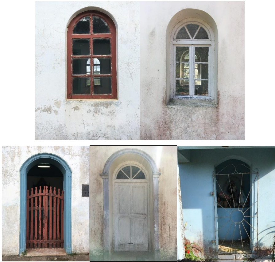
Figura 26 – Vergas em arco: Janelas capitel Nossa Senhora do Rosário da Pompéia e capitel São Patrício, Portas capitel Nossa Senhora do Rosário da Pompéia, São Patrício e Santo Antônio, Linha da Consciência
