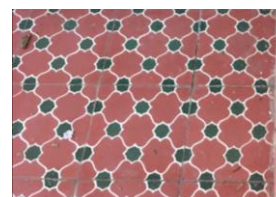
Piso ladrilho hidráulico
