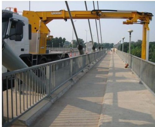
Figura 1.1 – Exemplo de utilização da lança telescópica visto de cima da ponte
