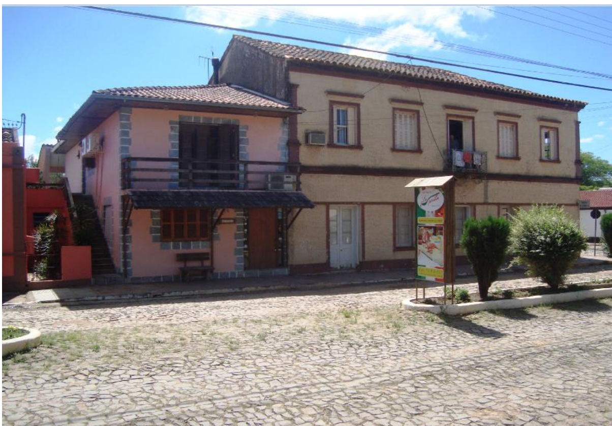
Figura 2 - Vista da fachada do Ristorante La Sorella
