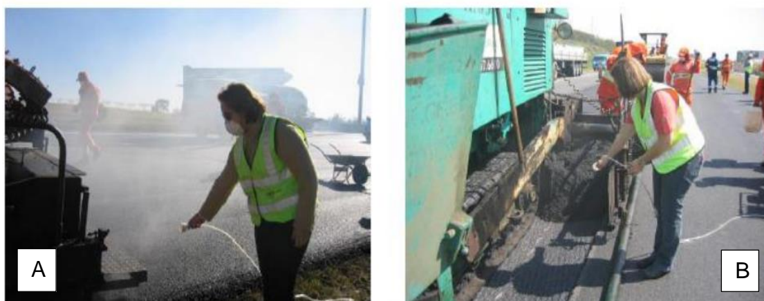
Figura 7 – Fumos asfálticos liberados pela mistura a quente (A) e pela mistura morna (B) quando da aplicação do material em pista.
