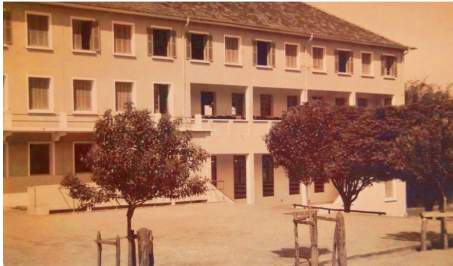
Figura 44 - Pré-Seminário São José depois da ampliação em 1959
