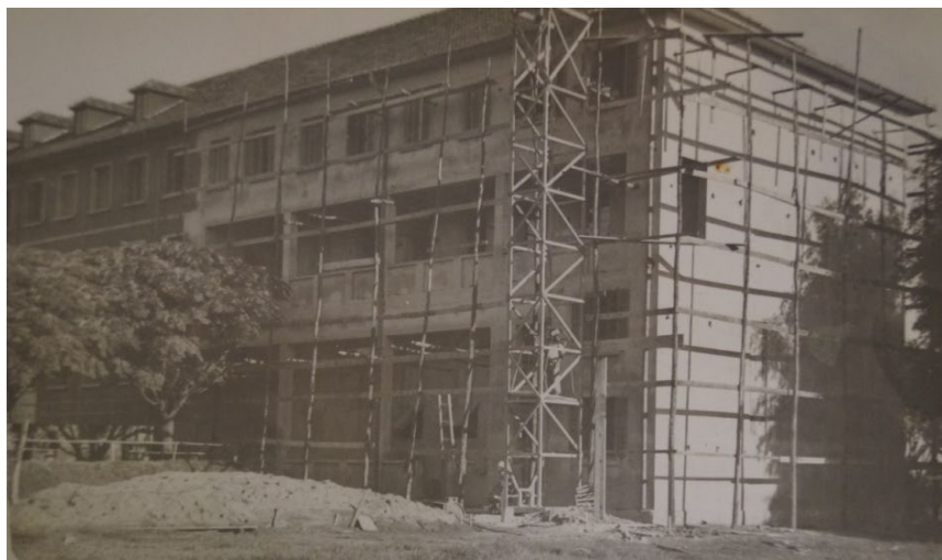
Figura 43 – Outra parte da ampliação do Pré-Seminário São José em 1958
