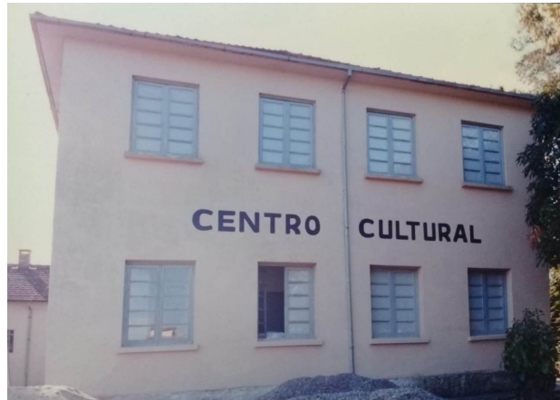
Figura 58 - Parte do prédio onde funcionava o Centro Cultural, 1993
