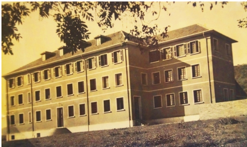
Figura 33 - Prédio do Pré-Seminário São José finalizado, em [195_].
