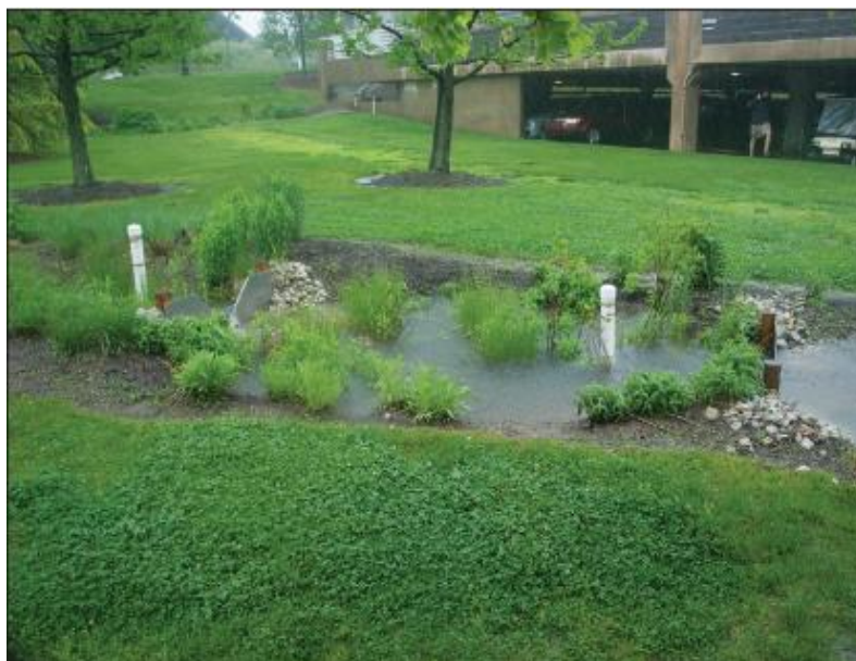
Figura 3 - Biorretenção em um jardim privado da Pensilvânia, EUA
