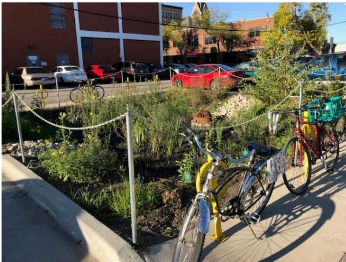
Figura 5 - Biorretenção em um estacionamento, em Minnesota, EUA
