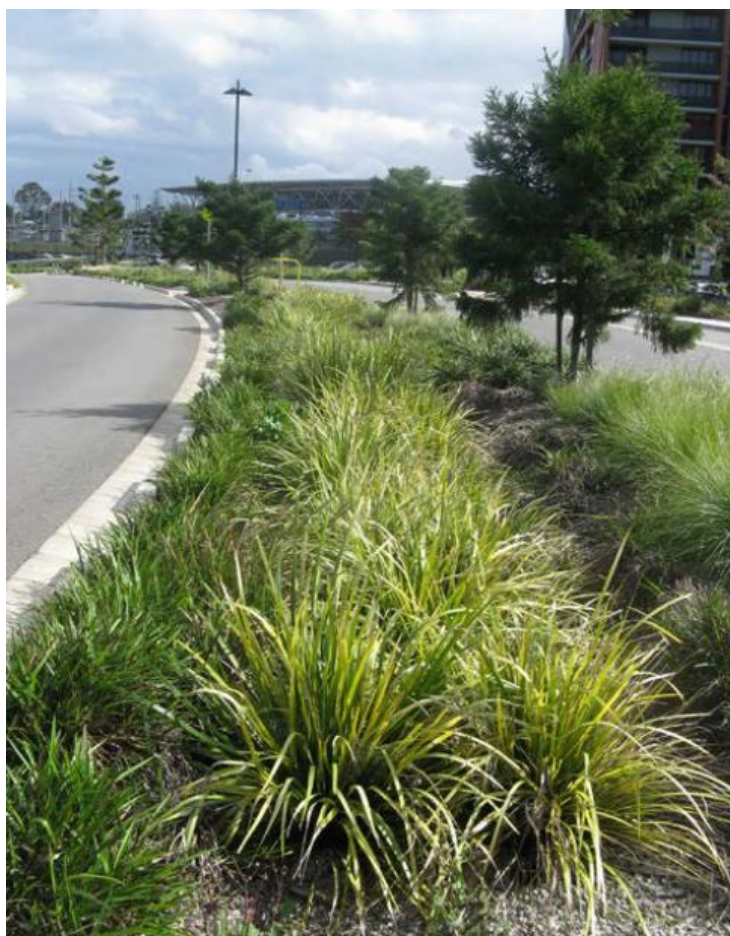
Figura 4 - Biorretenção ao longo de uma via pública da Austrália
