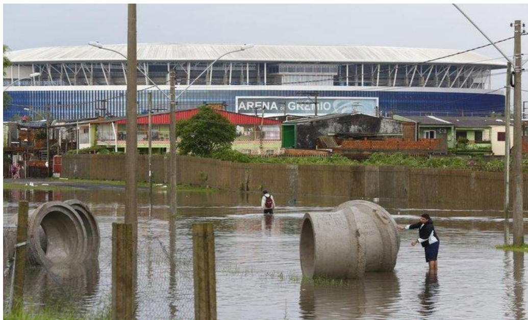
Figura 5 - Manilhas de concreto espalhadas pelo Bairro Humaitá.
