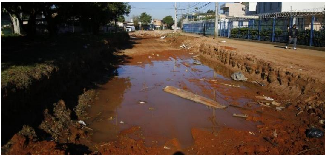
Figura 9 - Obra inacabada: implementação de drenagem urbana.
