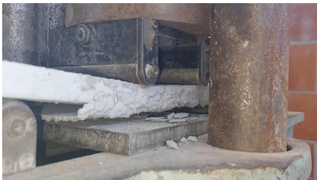
Figura 22 – Descolamento da camada de chapisco na face inferior.
