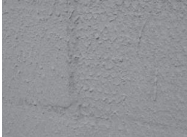
Figura 4 – Superfície de chapisco rolado
