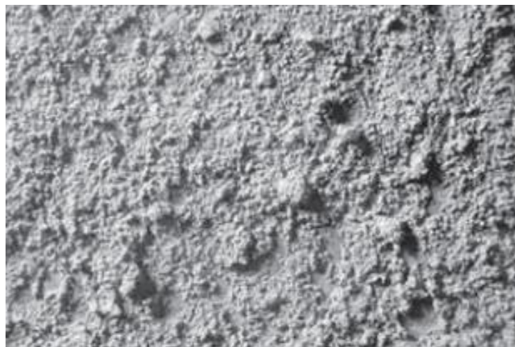
Figura 2 – Superfície de chapisco lançado com colher de pedreiro
