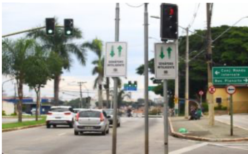
Figura 33: Semáforos inteligentes em São José dos Campos
