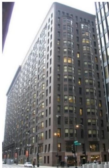
Figura 1 – Edifício Monadnock, Chicago, EUA.
