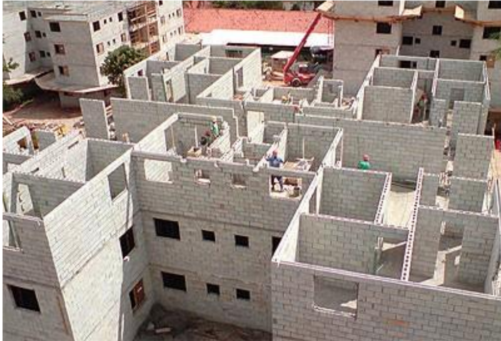
Figura 3 – Exemplo de construção em alvenaria estrutural de bloco de concreto.
