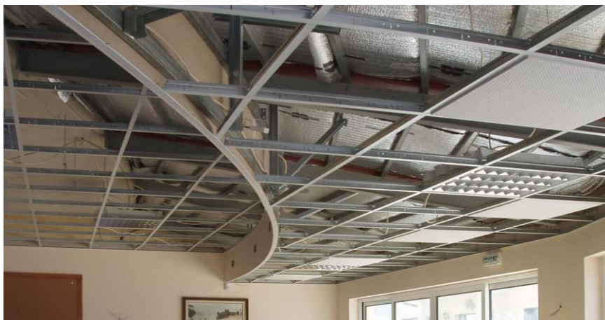
Figura 2 – Estrutura de um teto falso
