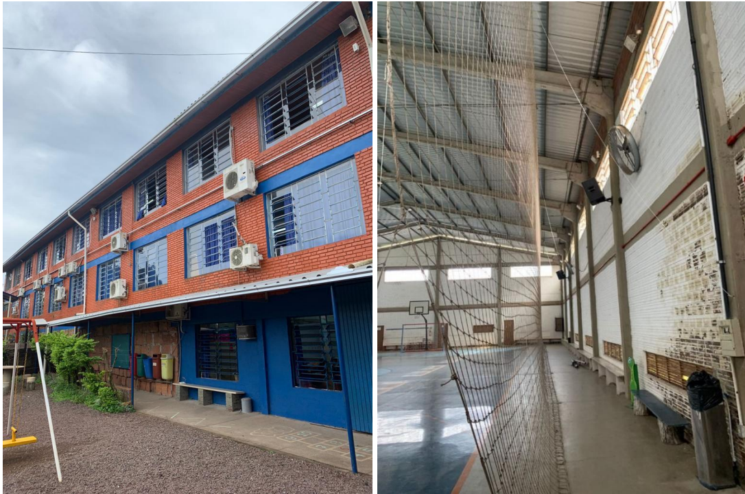
Figura 9 – (a) prédio principal e (b) ginásio
