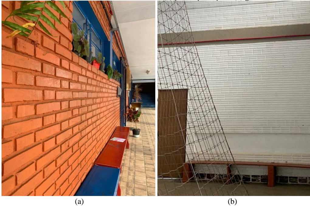
Figura 11 – Elementos construtivos: (a) prédio principal e (b) ginásio
