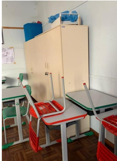
Figura 18 – Materiais combustíveis existentes no prédio principal.
