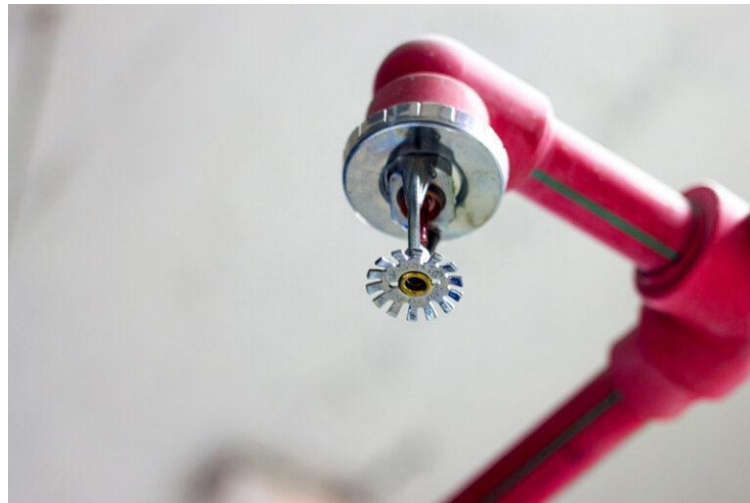
Figura 5 – Sprinkler automático
