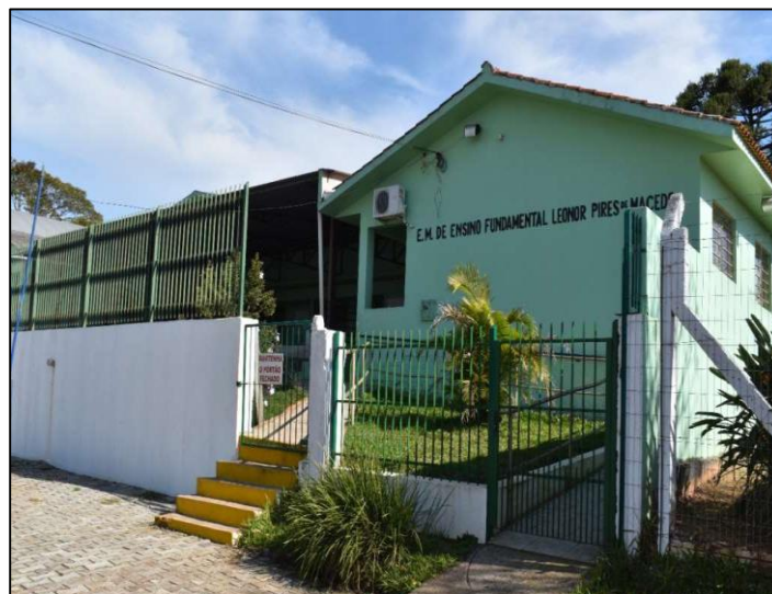
Figura 18 - Escola Municipal de Ensino Fundamental Leonor Pires de Macedo
