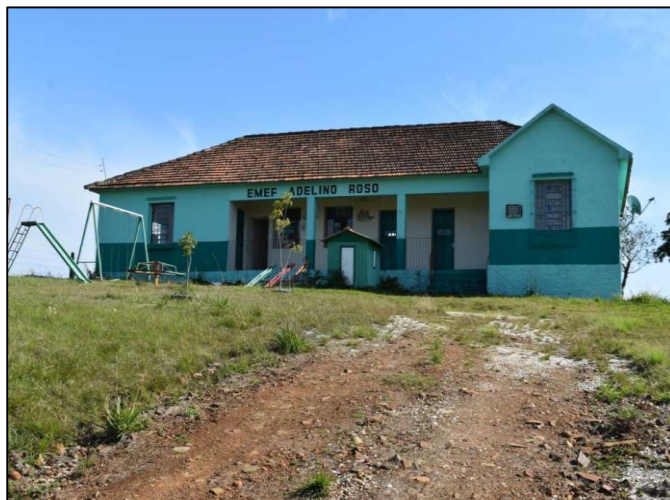
Figura 16 – Escola Municipal de Ensino Fundamental Adelino Roso
