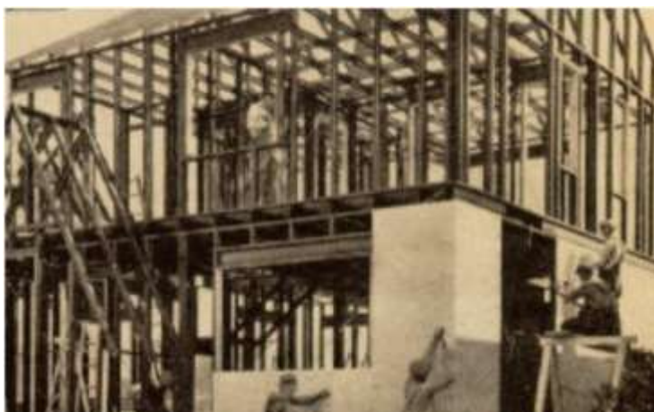
Figura 1 - Protótipo de residência em LSF
