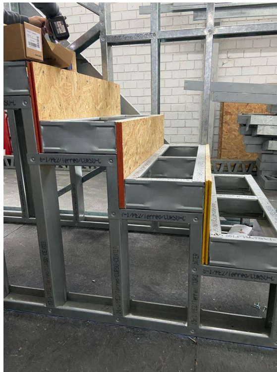
Figura 27 - Escada com painéis escalonados e painéis de degrau
