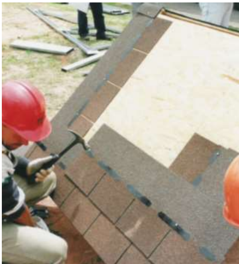
Figura 25 - Detalhe da membrana asfáltica em telha shingle
