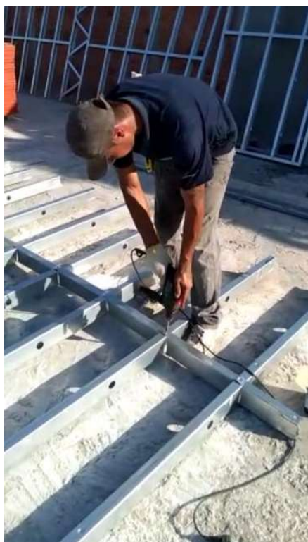
Figura 8 - Panielização executada no canteiro
