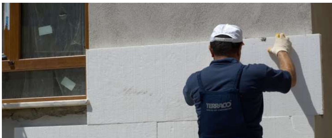
Figura 23 - Aplicação do EPS na fachada
