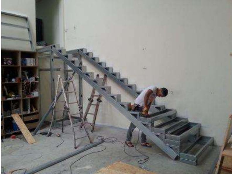
Figura 26 - Escada com viga caixa inclinada
