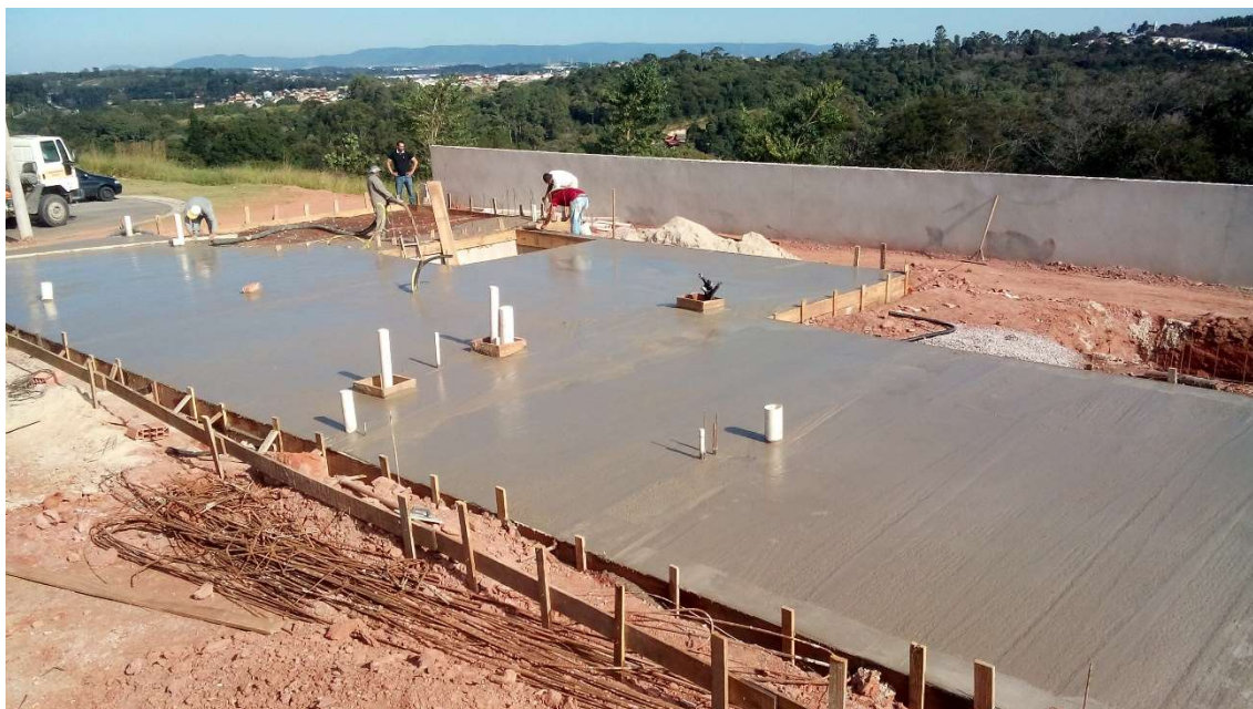
Figura 4 - Laje radier com esperas de instalações
