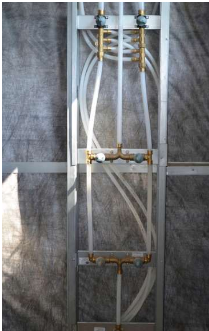
Figura 20 - Instalação hidráulica em PEX
