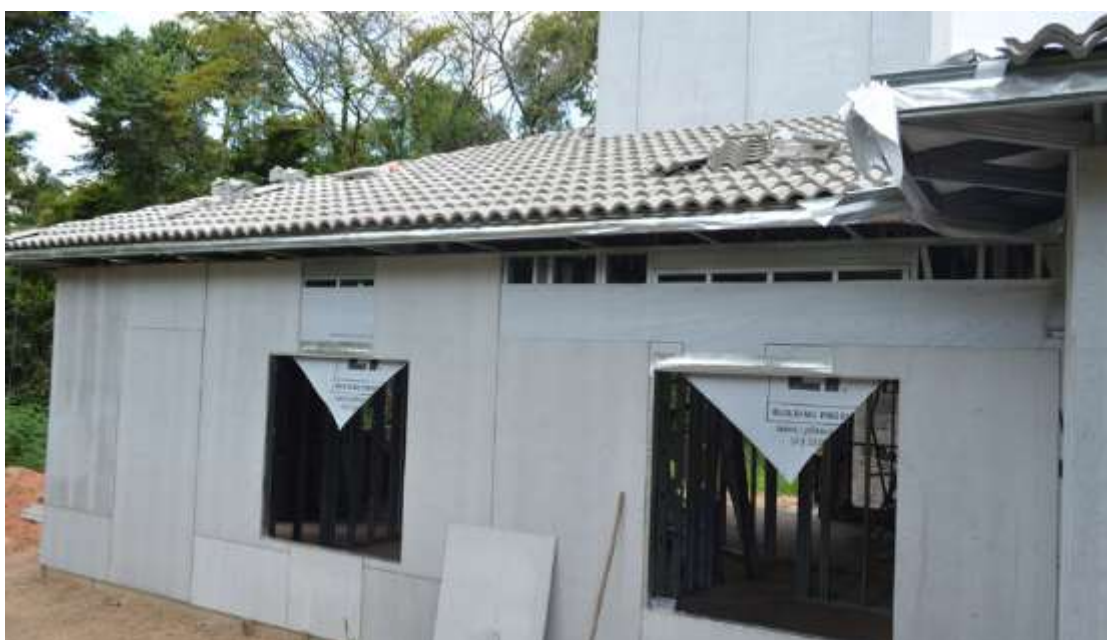
Figura 16 - Residência com plaqueamento externo em placa cimentícia
