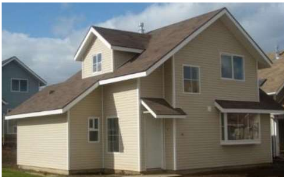
Figura 22 - Residência executada com siding vinílico na fachada
