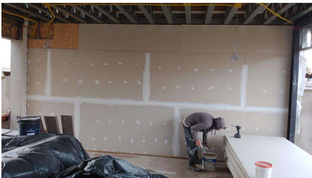
Figura 17 - Placas de gesso sobre OSB com tratamento de juntas e parafusos
