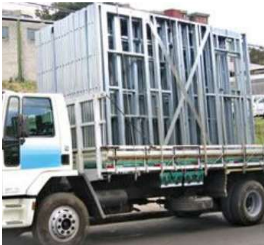
Figura 9 - Painéis industrializados sendo transportados
