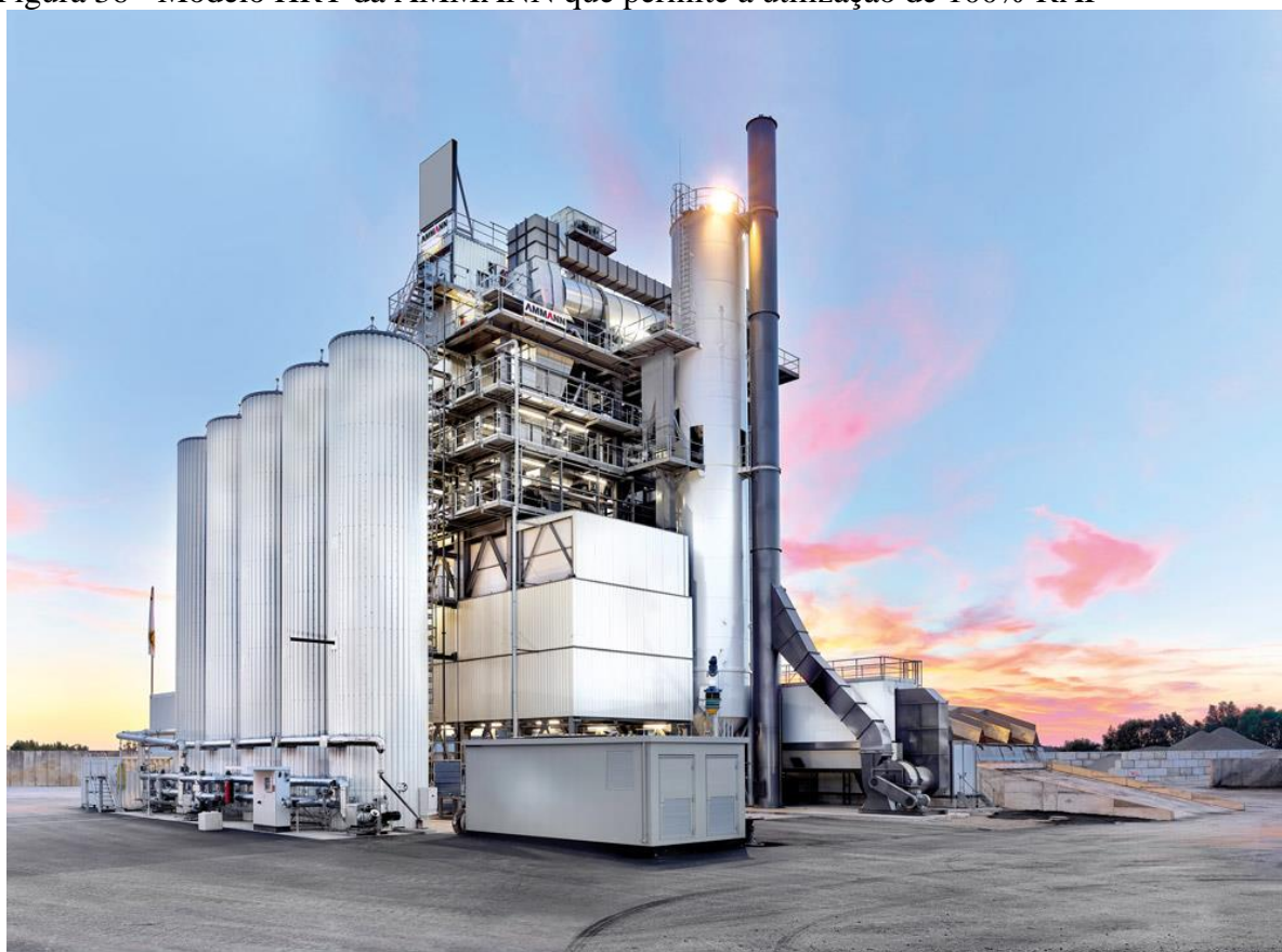
Figura 36 - Modelo HRT da AMMANN que permite a utilização de 100% RAP
