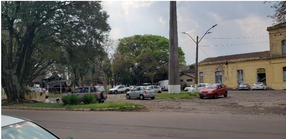
Figura 19 - Largo da estação.
