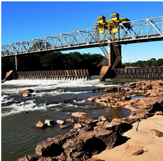
Ponte-barragem do Fandango sobre o rio Jacuí. Fotografia de Robespierre Giuliani, 2013.
