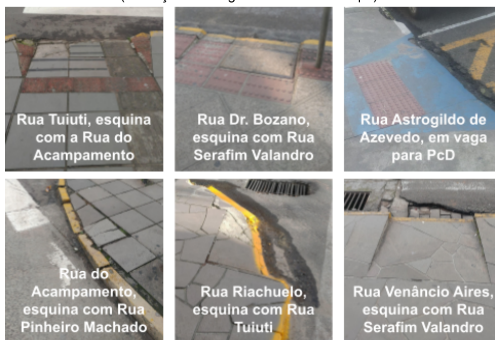
Figura 60 - Rampas de acesso às calçadas (descrição da imagem em nota de rodapé) 82
