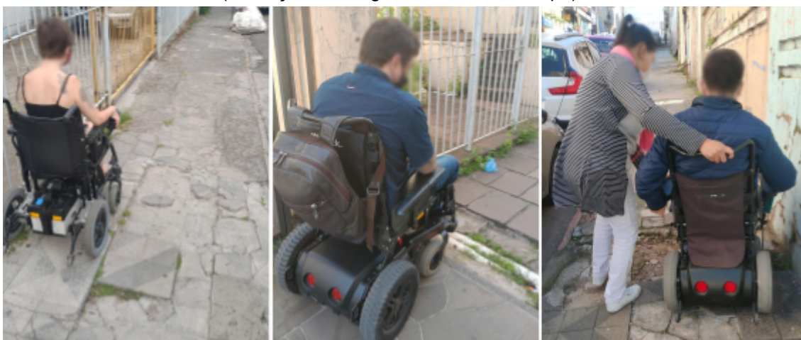
Figura 29 - Passeios acompanhados 1, 6 e 7: buracos, irregularidades e desníveis (descrição da imagem em nota de rodapé) 51
