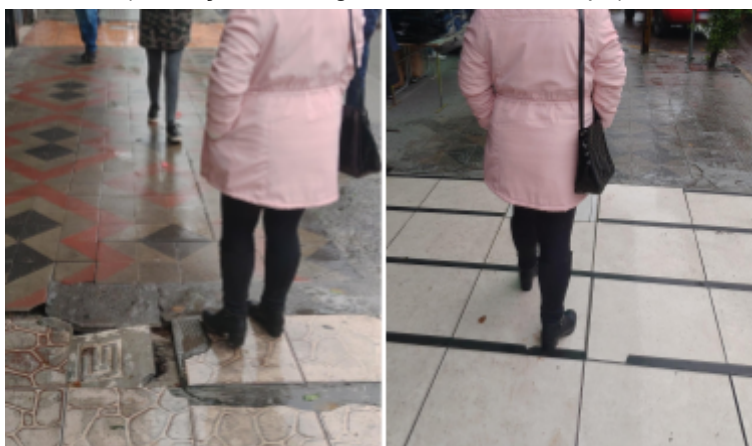
Figura 35 - Passeio acompanhado 8: desníveis e pavimento derrapante (descrição da imagem em nota de rodapé) 57
