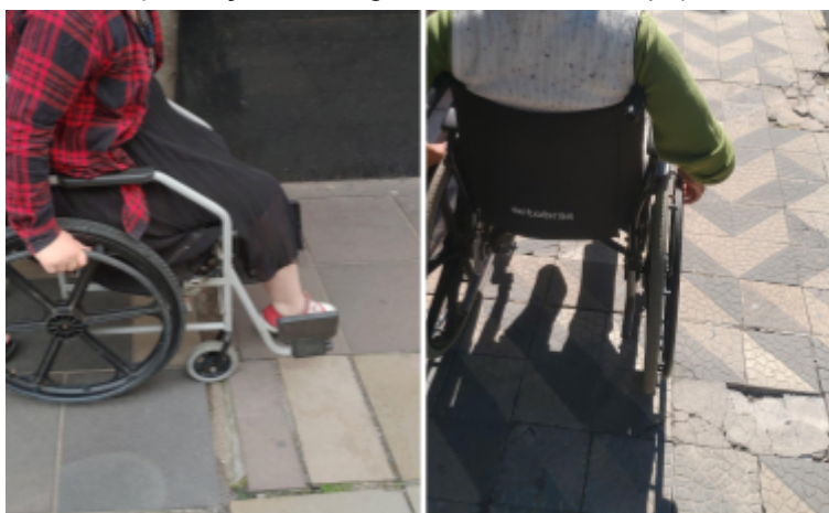
Figura 32 - Passeios acompanhados 2 e 3: buracos e irregularidades (descrição da imagem em nota de rodapé) 54
