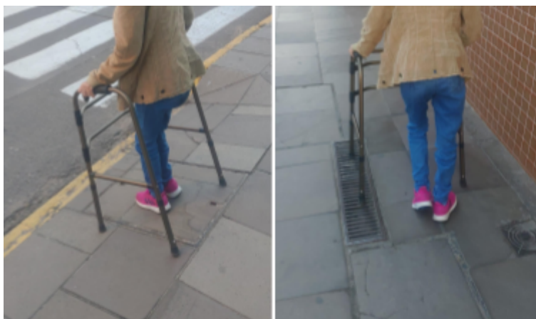
Figura 33 - Passeio acompanhado 9: rampa inadequada e irregularidades (descrição da imagem em nota de rodapé) 55
