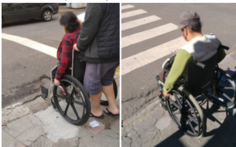
Figura 31 - Passeios acompanhados 2 e 3: rampas inadequadas (descrição da imagem em nota de rodapé) 53
