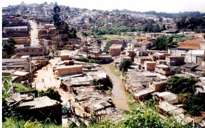
Figura 4. Ocupação de margens de arroio Belo Horizonte/MG.
