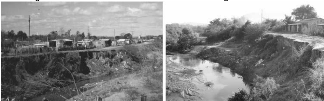
Figura 4 - Moradias com risco de erosão de margem – Vila Oliveira
