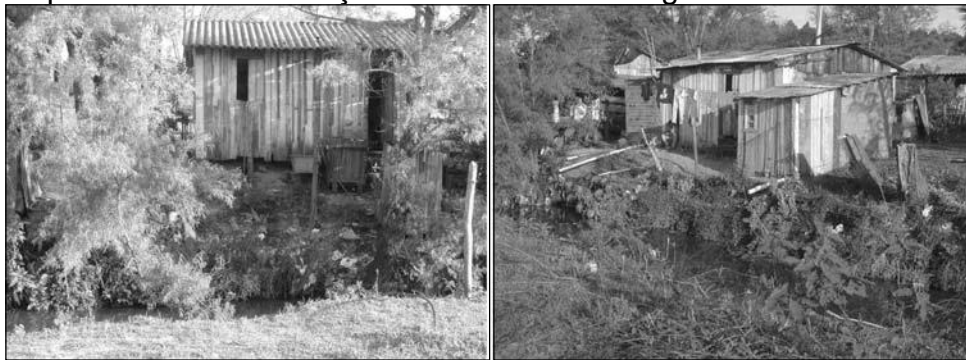
Figuras 9 - Moradias situadas nas margens do arroio Cancela sujeitas a processos de inundação e de erosão de margem – Vila Urlândia
