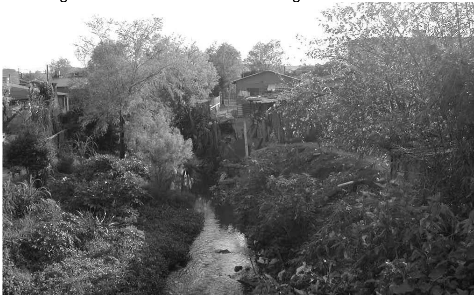
Figura 3 – Risco de erosão de margem na Vila Santos.
