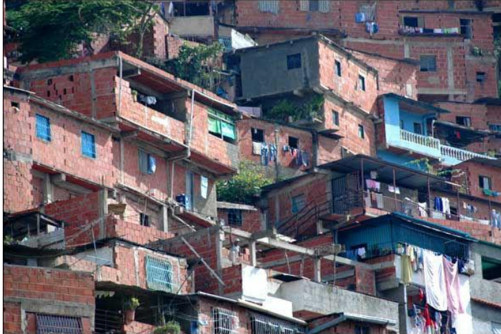
Figura 2. Fotografia de detalhe de ocupação em encosta/RJ.
