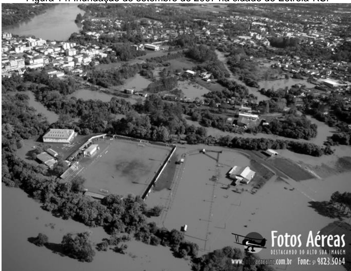
Figura 14. Inundação de setembro de 2007 na cidade de Estrela-RS.
