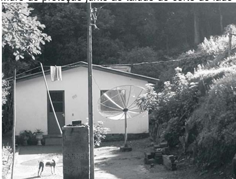
Figura 17. Muro de proteção junto ao talude de corte do lado da moradia.
