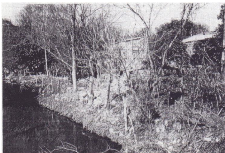
Fotografia 01 - Ocupação com moradias na margem da drenagem
