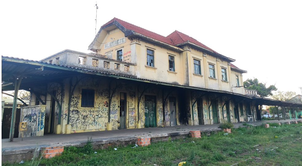
Figura 9 – Estação Ferroviária de Alegrete – área de embarque
