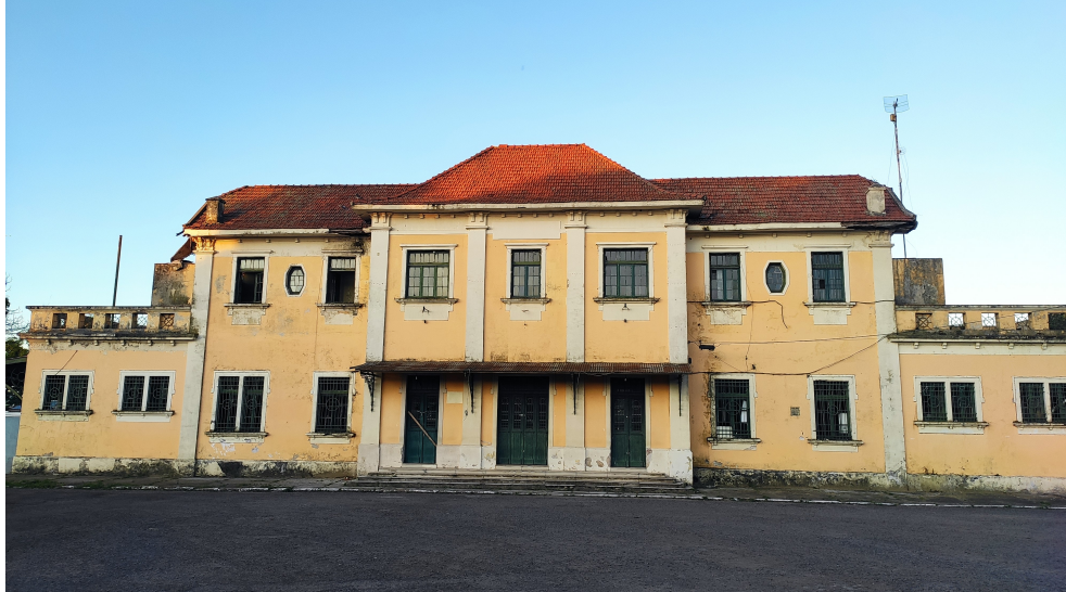
Figura 8 – Estação Ferroviária de Alegrete – Fachada
