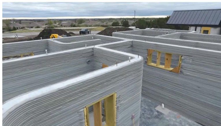
Figura 1 - Construções utilizando a tecnologia de impressão 3D
