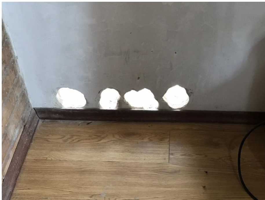
Figura 82 - Sistema interno de calefação
