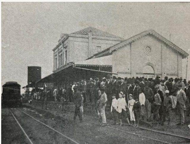
Figura 96 - Linha férrea e Estação Ferroviária que cruzavam à norte do centro da cidade.
