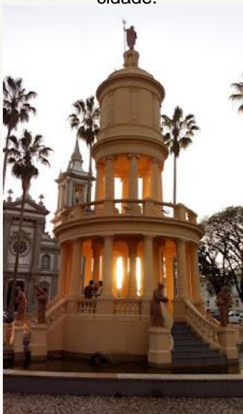
Figura 12 - Château d'Eau em Cachoeira do Sul, funcionava como um reservatório elevado para distribuição de água na cidade.
