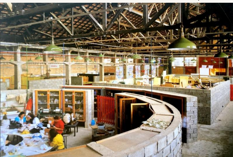
Figura 34 – Disposição funcional das oficinas dentro do galpão, separadas por meia paredes de bloco de concreto aparentes.
