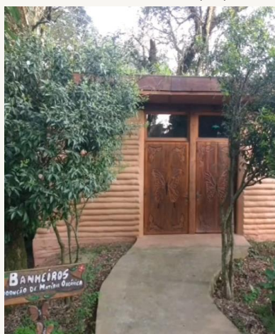
Figura 75 - Entrada dos banheiros secos (04).
