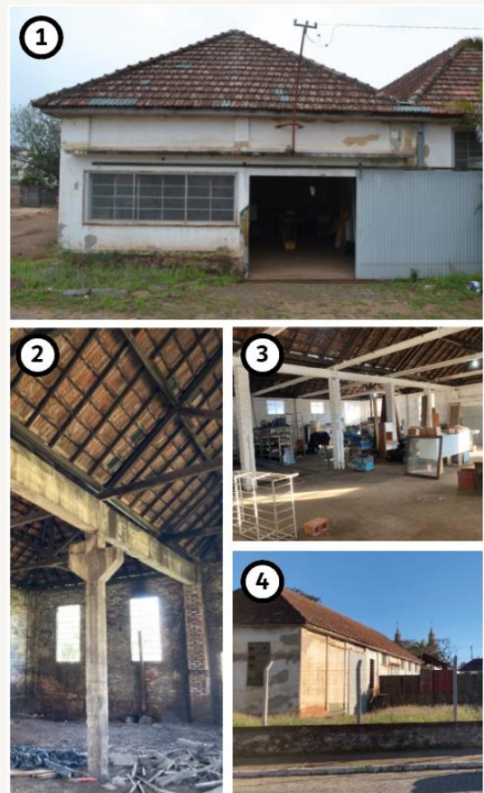
Figura 150 - (1) Fachada para rua interna; (2) galpão da caldeiraria; (3) área da oficina de marcenaria; (4) Fachada para a rua Pinheiro Machado.
