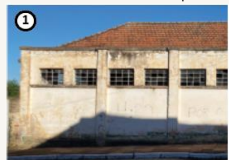
Figura 148 - (1) Fachada frontal. (2) Área ampliada ao lado. (3) Área interna com telhado aparente.
