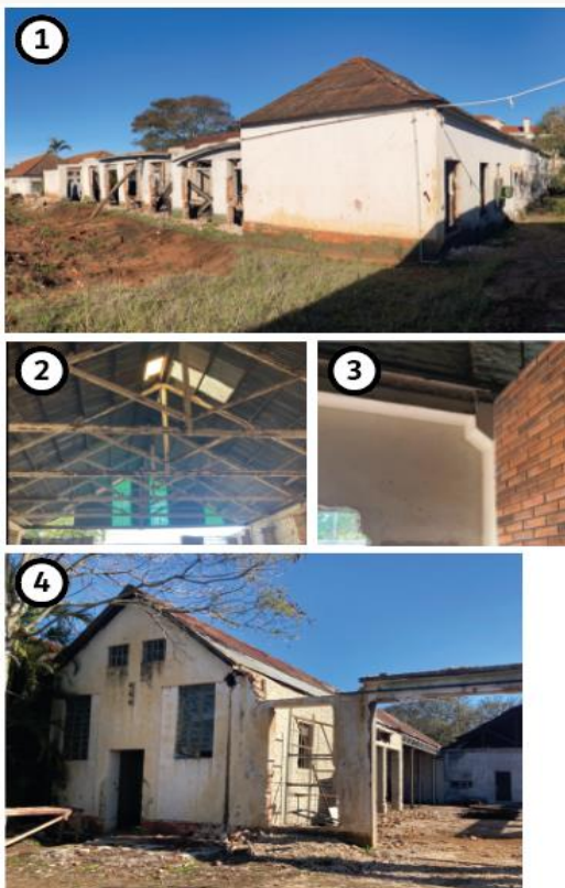
Figura 144 - (1) Parte em demolição e fachada parte administrativa; (2) Telhado aparente com telhas de aluzinco. (3) Detalhe da estrutura pré-moldada e autoportante. (4) Fachada interna com parte destruída.
