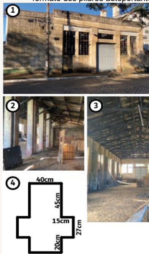
Figura 146 - (1) Fachada principal; (2) Parte lateral da fundição; (3) Área principal da fundição; (4) Detalhe do formato dos pilares autoportante.
