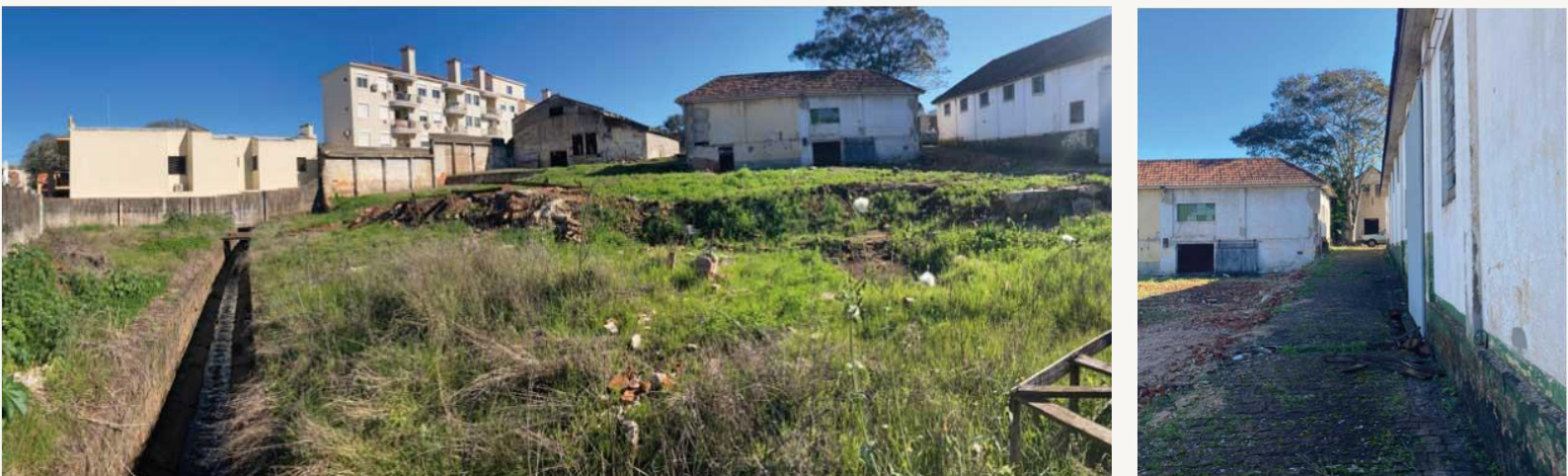
Figura 138 - imagens da situação atual das edificações (esquerda) córrego canalizado por onde passava a antiga linha férrea; (direita) rua interna em paralelepípedo conectando os galpões.
