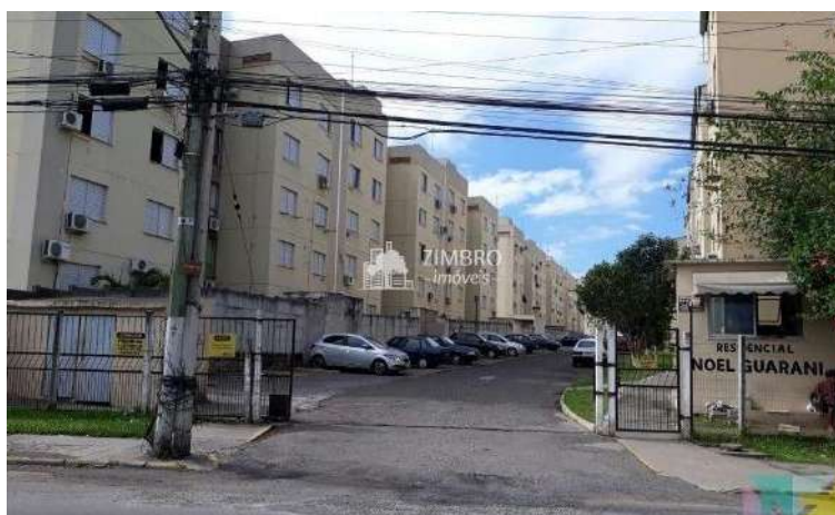
Figura 13- Residencial Noel Guarani em Santa Maria/RS, construído através do PAR.
