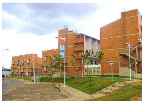
Figura 48 – Materialidade e espaços de convivência
