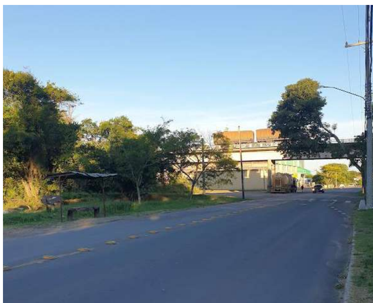
Figura 71 - Viaduto no cruzamento da Av. Osvaldo Cruz com a BR 158.
