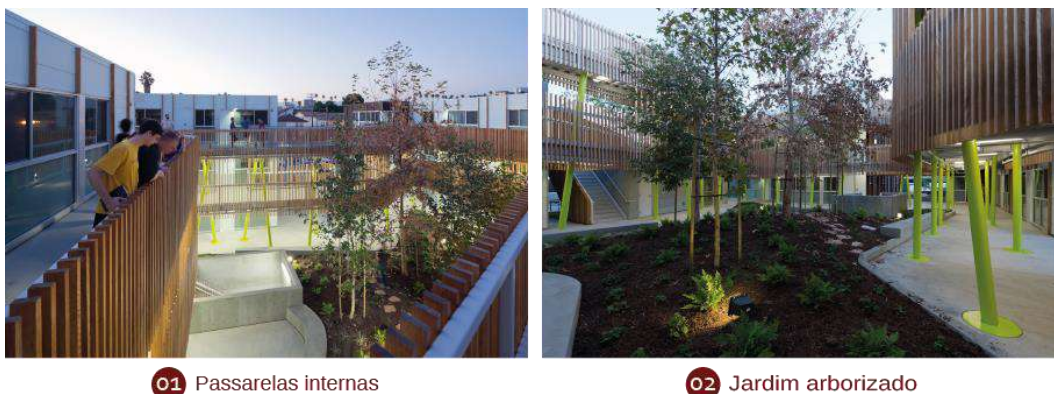
Figura 58 – Imagens do interior do conjunto
