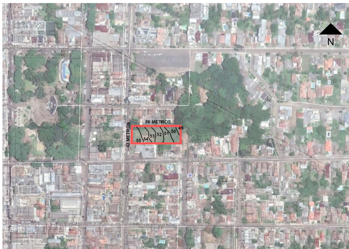
Figura 53 - Vista aérea do entorno do terreno. Fonte: Elaborado pela autora.
