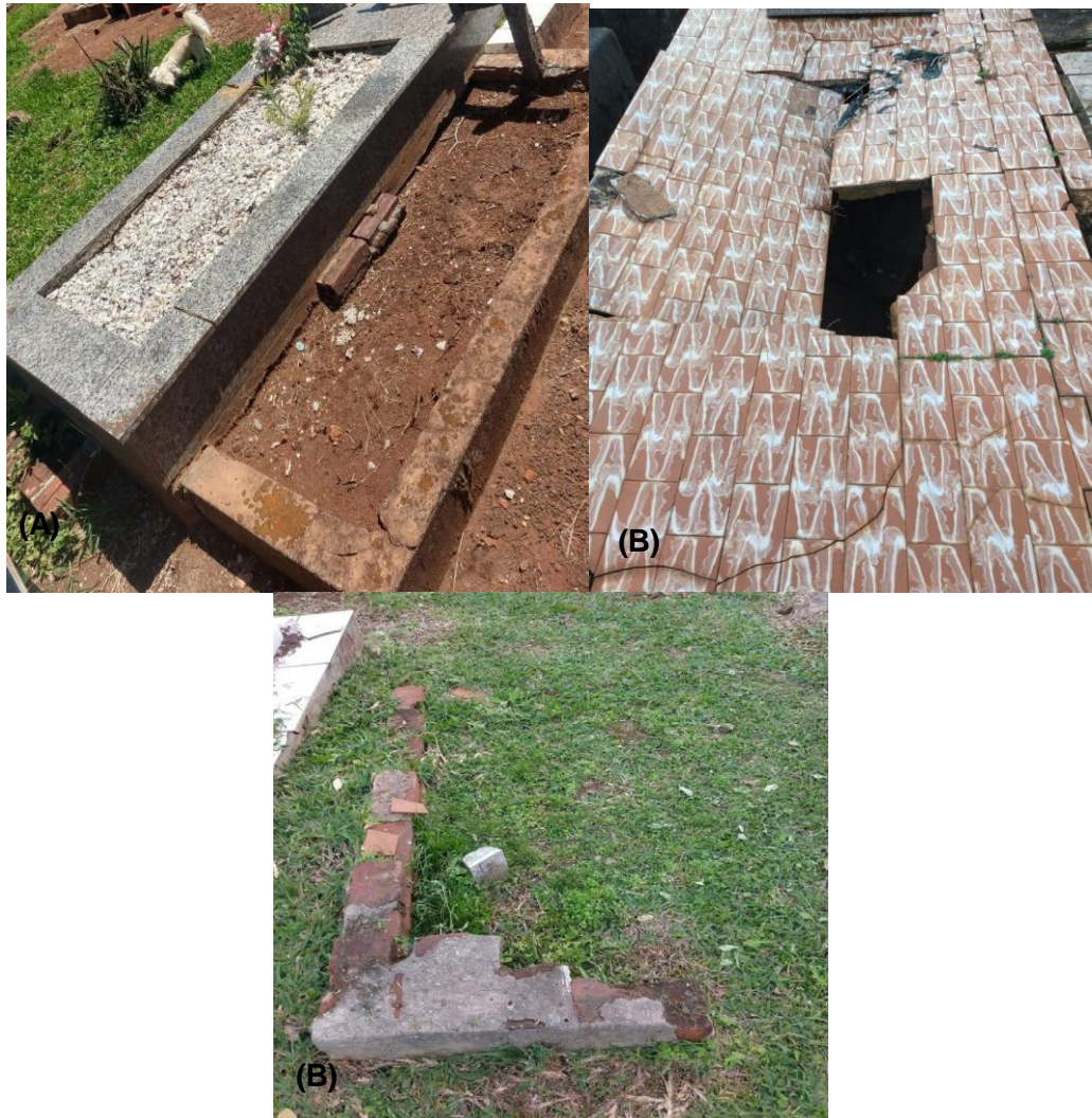
Figura 9 - Túmulos construídos unidos um ao outro (A) e em condições precárias (B)
