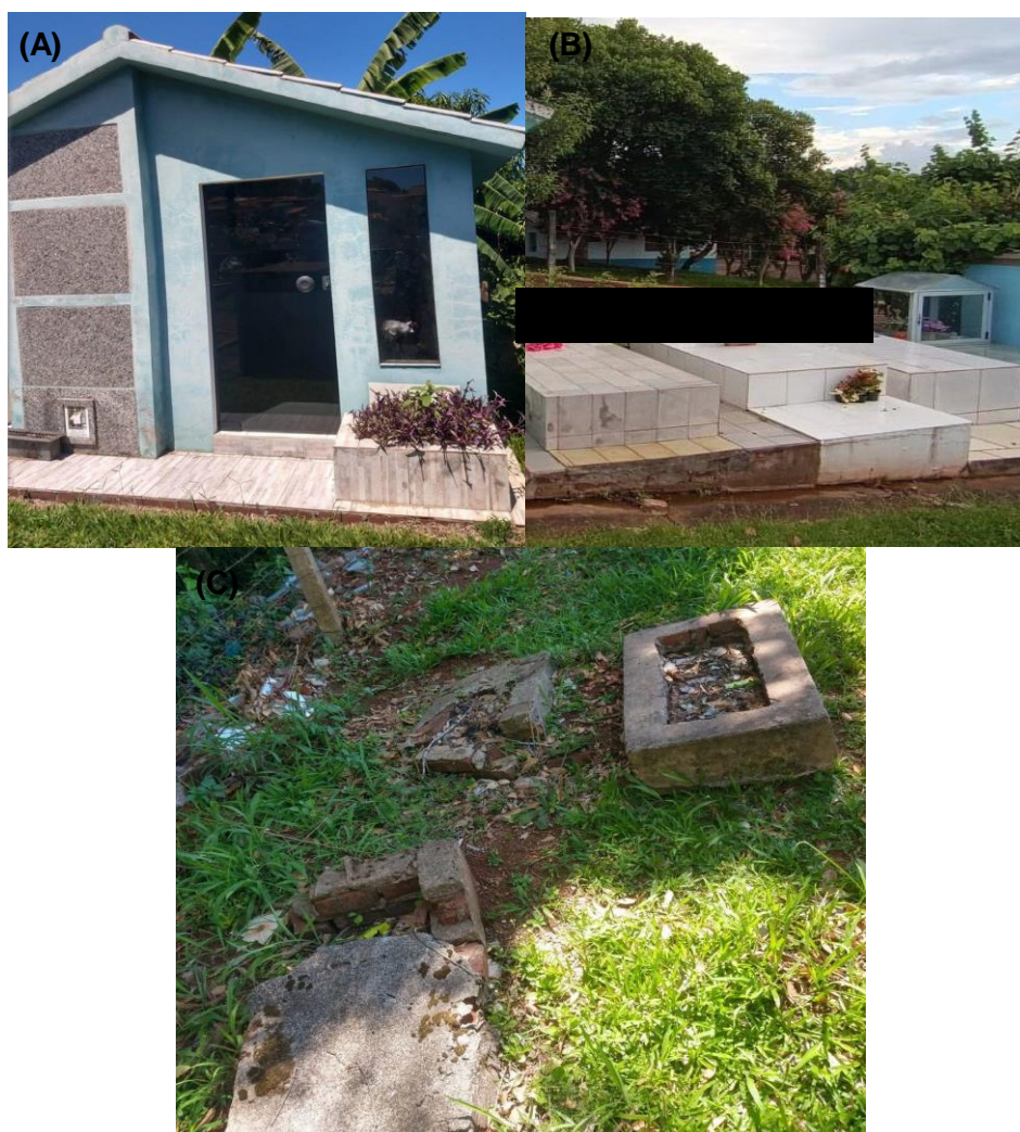
Figura 8 - Túmulos Jazigos (A), túmulos baixos sem contato com o solo (B) e túmulos com contato direto com o solo (C).
