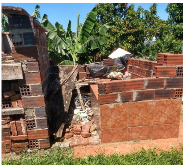
Figura 11 - Descarte inadequado de resíduos na área cemiterial.
