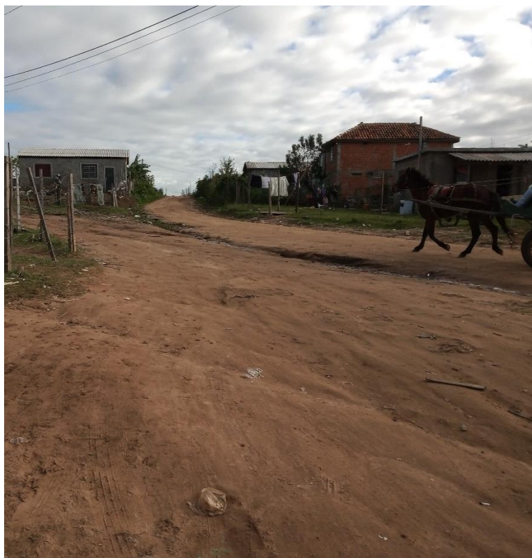
Figura 10 - Situação de esgoto do Bairro Nova Santa Marta
