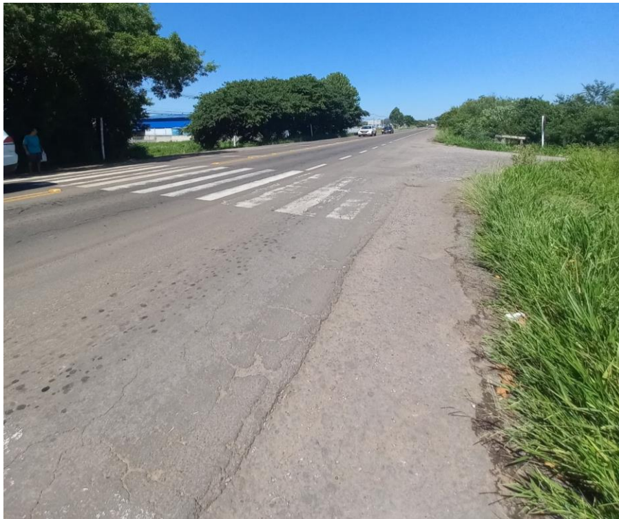
Figura 23 - Infraestrutura da via
