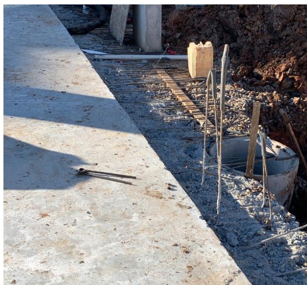
Figura 3 – Exemplo de junta de concretagem.
