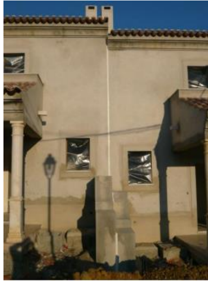
Figura 6 – Exemplo de junta de recalque.
