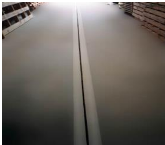
Figura 5 – Exemplo de junta de piso.
