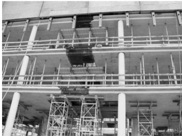
Figura 4 – Exemplo de faixa de concretagem.
