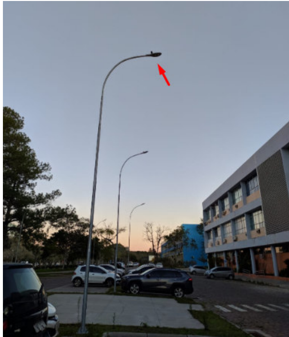
Figura 16 – Luminária Instalada no CT da UFSM
