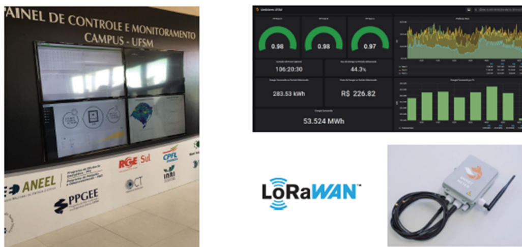
Figura 21 - Central de medição e medidores de comunicação sem fio
