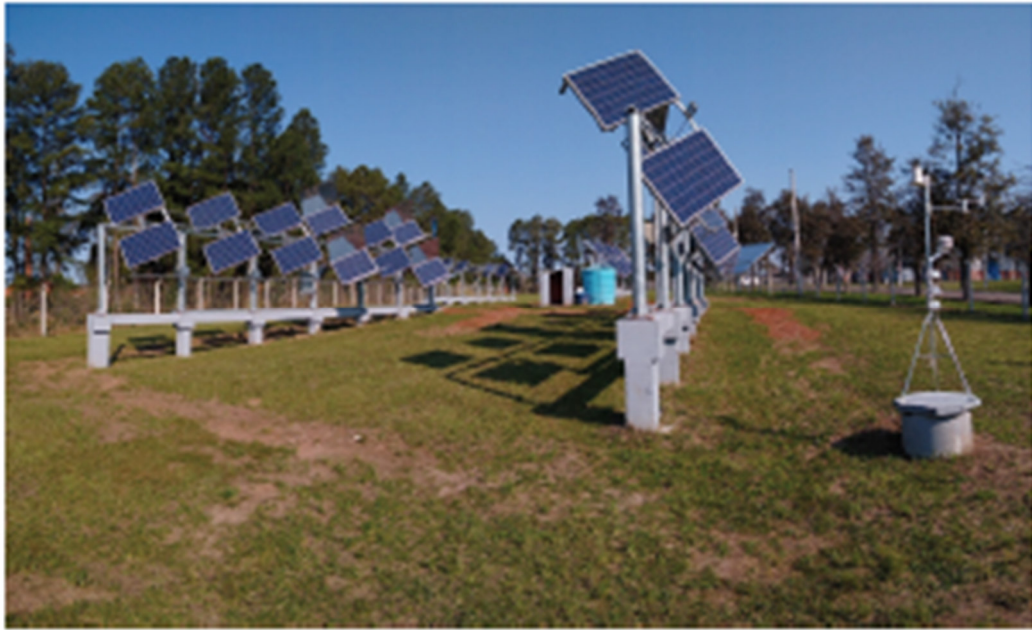
Figura 20 - Planta experimental reconfiguração geotérmica
