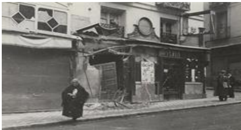
Figura 35 – Fachada da confeitaria destruída no início da Guerra, 1939.
