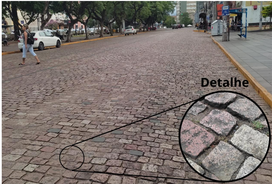
Figura 9 - Pavimentação em paralelepípedos (Av. Rio Branco)
