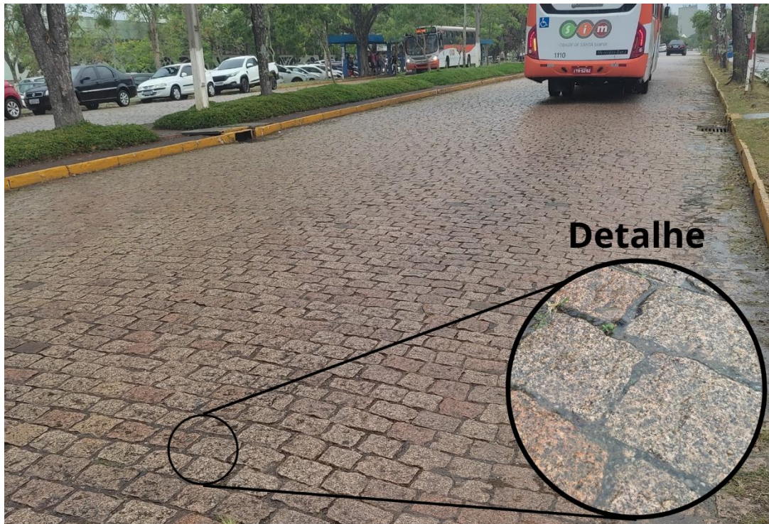
Figura 11 - Pavimentação em paralelepípedo (UFSM)
