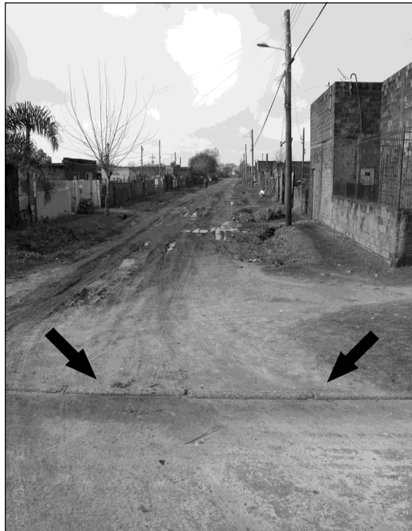
Figura 11 - Detalhe do desnível entre as ruas S e E
