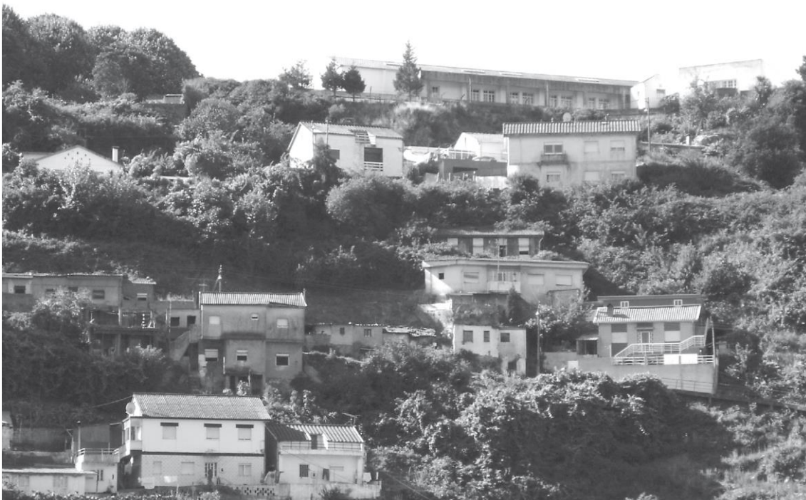
Figura 6 - Fotografia de frente onde pode-se observar uma porção côncava da encosta e as habitações ocupando diferentes patamares (Fonte: Trabalho de Campo, 2008).
