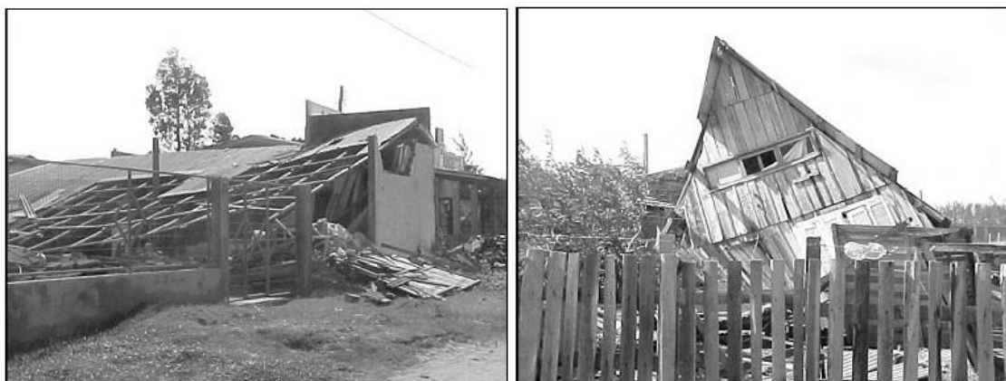
Figuras 10- Moradias destruídas e danificadas pelo Catarina no município de Torres em março de 2004. Fonte: Defesa Civil do Estado do Rio Grande do Sul.
