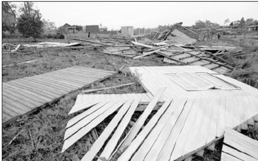
Figura 7 – Destruição em moradias atingida por um vendaval ocorrido em 12 de setembro de 2002, na cidade de Santa Maria.
