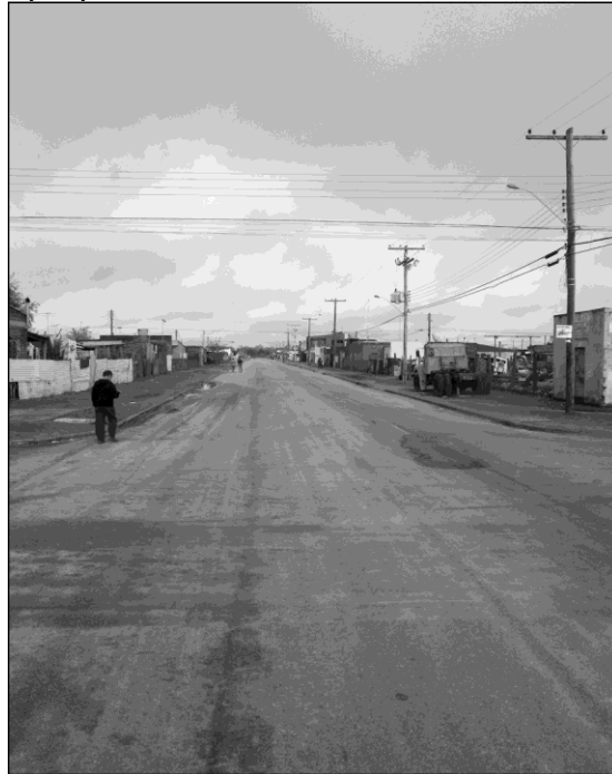
Figura 10 - Rua S, a única asfaltada. Notar as casas marginais e ruas perpendiculares em nível mais baixo
