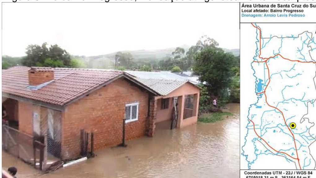
Figura 5. No bairro Progresso, inundaç o atinge loteamento Eucaliptos.
