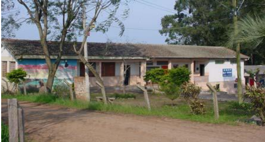
Figura 12 – Escola Municipal de Ensino Fundamental Major Tancredo Penna de Moraes – Palma, Distrito de Santa Maria/RS.
