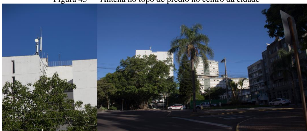
Figura 45 — Antena no topo de prédio no centro da cidade
