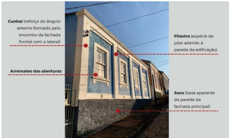
Figura 4 - Detalhes presentes nas fachadas que variam entre as unidades do conjunto
