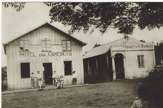
Imagem 5 – Primeiro Hotel do Comércio com estrutura em madeira Fonte: Henrique Lima
