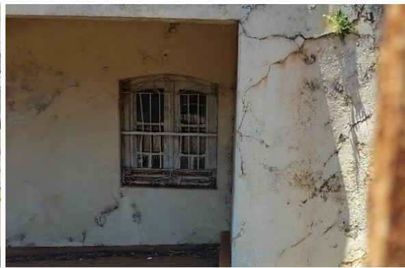
Imagem 5 - Detalhe Janela Original
