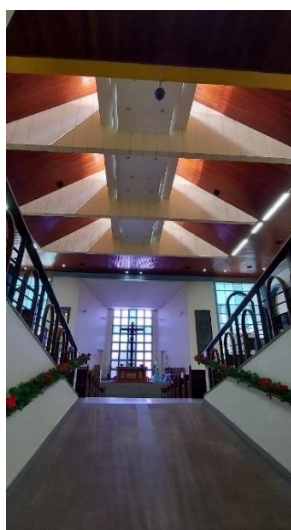
Imagem 6 – Vitrais no fundo da igreja (Fachada Norte)
