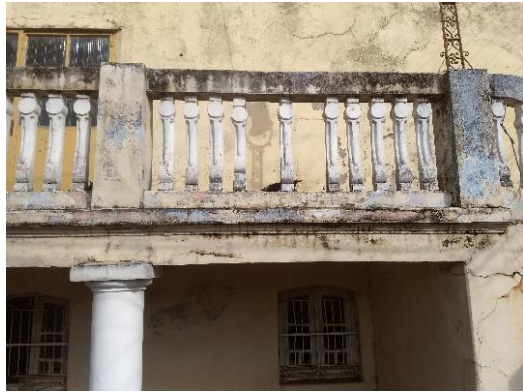
Imagem 4 - Detalhe Guarda Corpo Original
