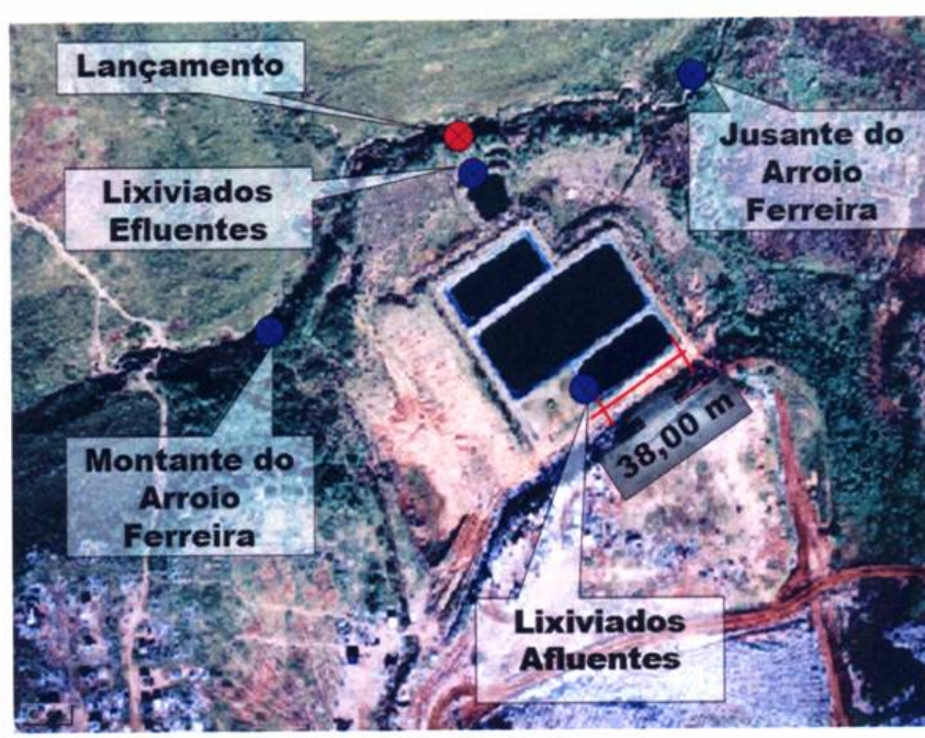
Figura 1 - Área do Aterro Controlado da Caturrita (Santa Maria – RS) mostrando as lagoas de estabilização e os pontos de monitoramento adotados nesse trabalho (GOMES, 2005).
