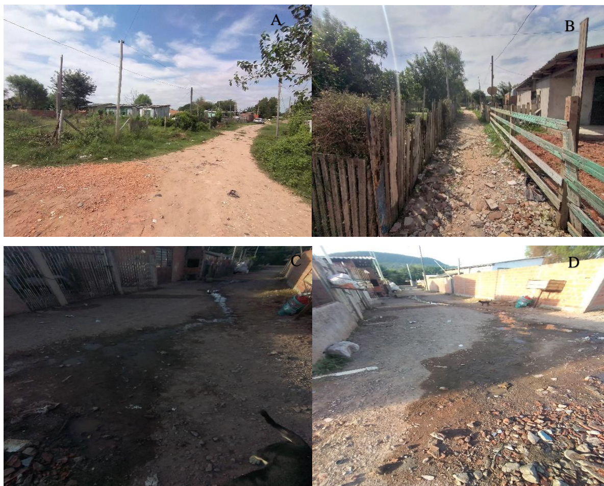
Figura 21. Precariedade das condições de infraestrutura viária e habitacional - Área urbana de Santa Maria, RS
