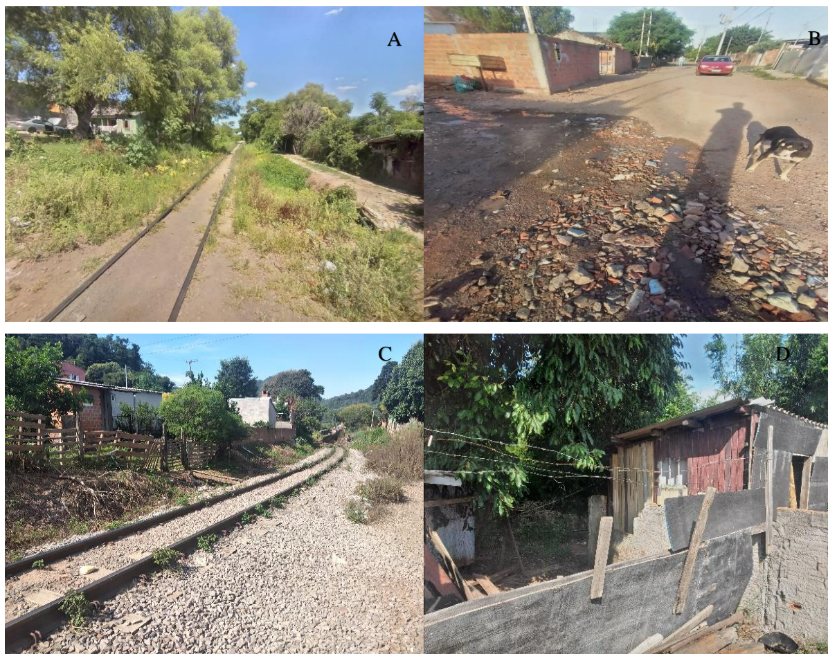
Figura 10. Ocupações irregulares nas proximidades da ferrovia - Área urbana de Santa Maria, RS
