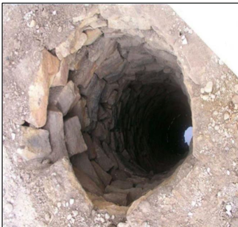
Figura 1 - Registro de poço profundo para captação de água, na China.
