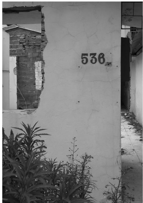
Figura 15 – Registro inicial de uma ruína em processo de degradação, 2020. Fotografia: Gabriela Capa.
