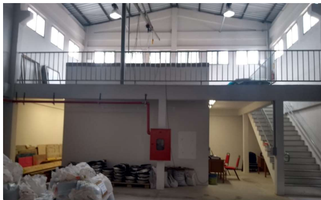
Figura 14 - Câmara de testes do laboratório de acústica da UFSM
