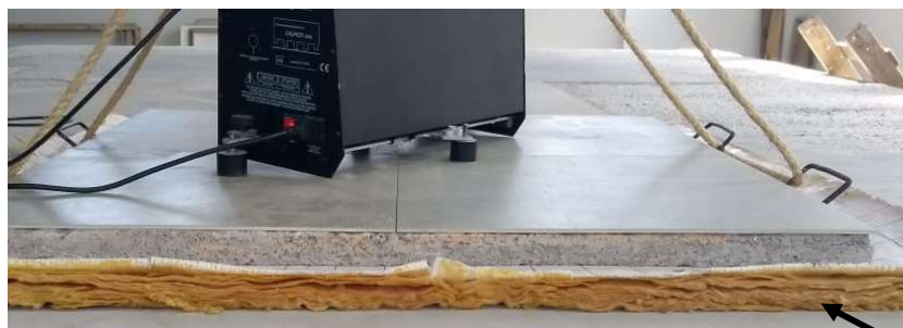
Figura 32 - Painel de lã de vidro sob o contrapiso
