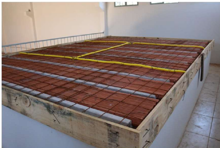
Figura 18 - Montagem da laje
