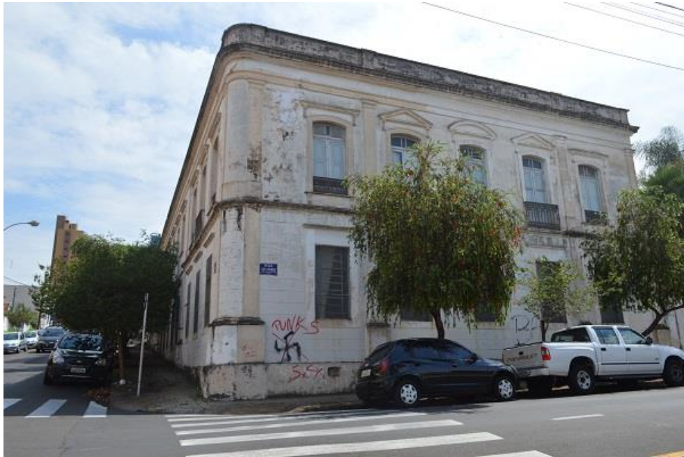
Figura 1 - Palacete Cunha Bueno, vista externa. Fonte: fotografia da autora, 2016
