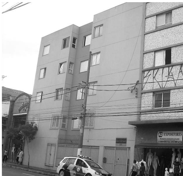
Figura 6 - Fachada do Residencial São Caetano, na Rua São Caetano. Fonte: fotografia de Marcos Felipe Alves da Silva, 15 de abril de 2019.
