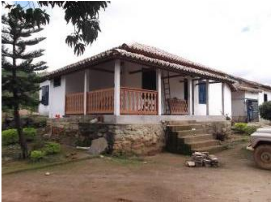
Figura 3 - Fazenda Harmonia, residência Sede Fonte: IPHAN, 2013.
