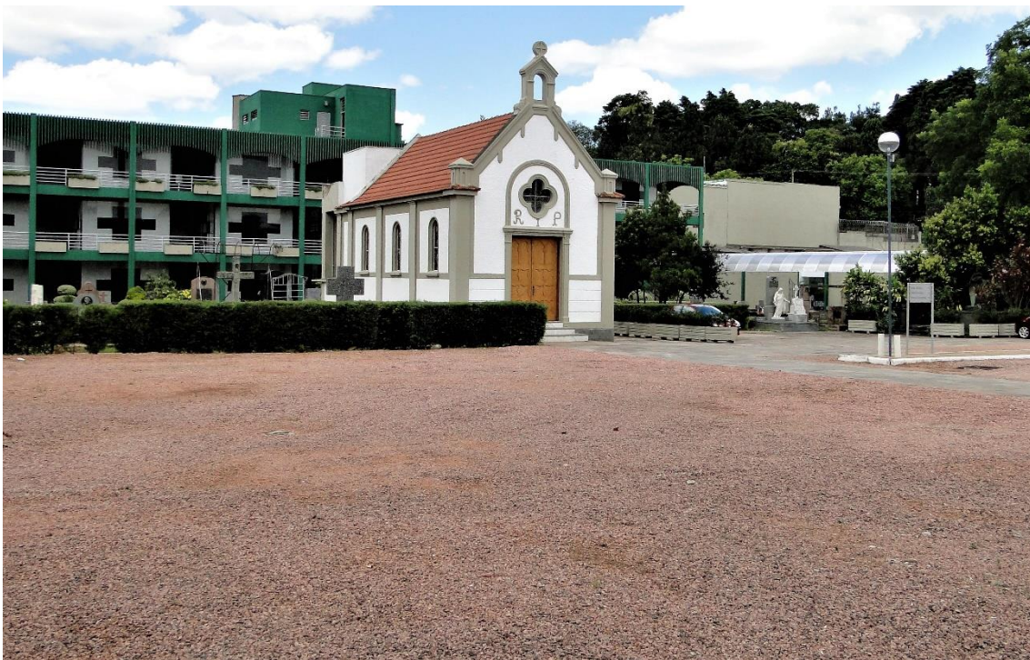
Figura 2 - Cemitério São José II, Porto Alegre - RS. Observar no primeiro plano pavimentação de pedra britada onde havia túmulos, capela foi preservada. Fonte: fotografia de André Huyer, 12 de janeiro de 2011.
