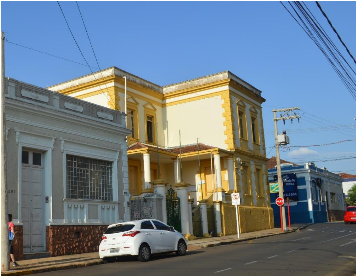
Figura 7 - Residência Paulino Carlos de Arruda Botelho. Fonte: fotografia da autora, 2019.
