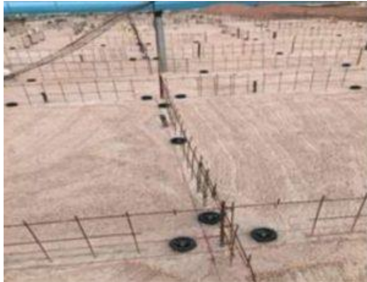
Figura 12 - Marcação da Laje
