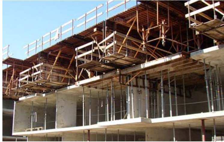
Figura 8 - Sistema Outinord: Formas Metálicas tipo Túnel.
