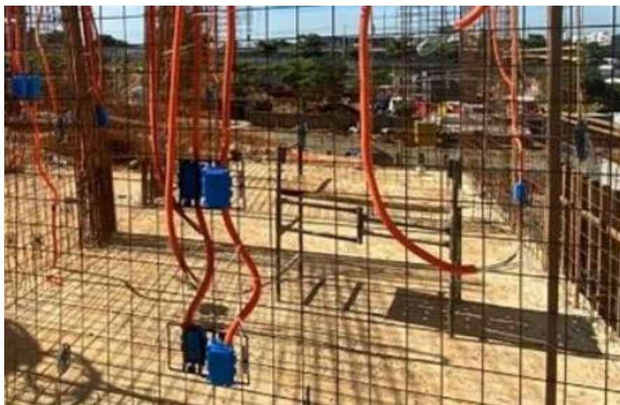
Figura 14 - Instalações Elétricas
