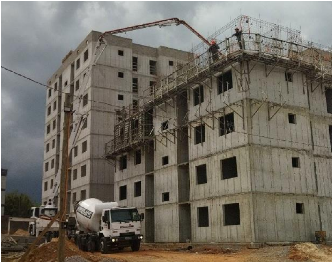
Figura 17 - Concretagem de edifício em paredes de concreto.
