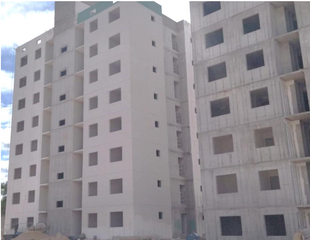
Figura 21 - Fachada com acabamento e com revestimento em textura projetada.
