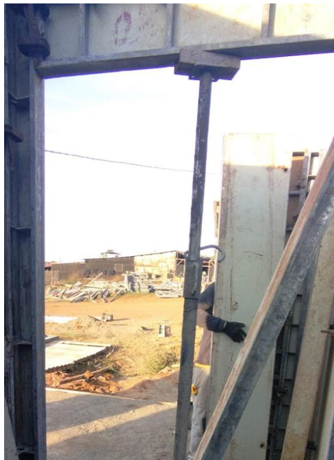
Figura 10 - Escoramento Metálico
