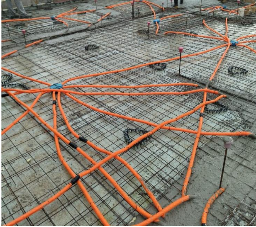
Figura 15 - Instalações Elétricas na Laje
